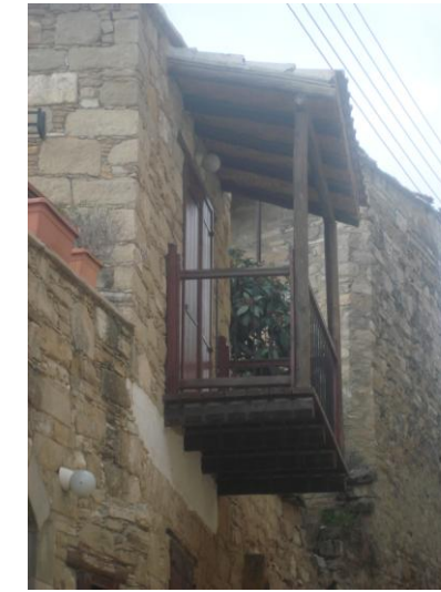
Το σκέπαστρο του εξώστη είναι αναπόσπαστο μέρος του και βρίσκεται σε πιο χαμηλό επίπεδο από τη στέγη.
