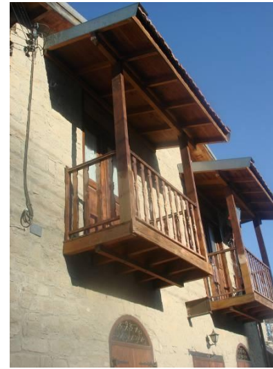
Το σκέπαστρο του εξώστη είναι αναπόσπαστο μέρος του και βρίσκεται σε πιο χαμηλό επίπεδο από τη στέγη.
