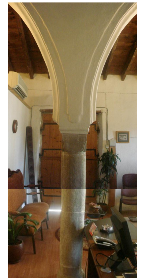
Κατάληξη καμάρας. Το τόξο φαίνεται να εφάπτεται της τοιχοποιίας
