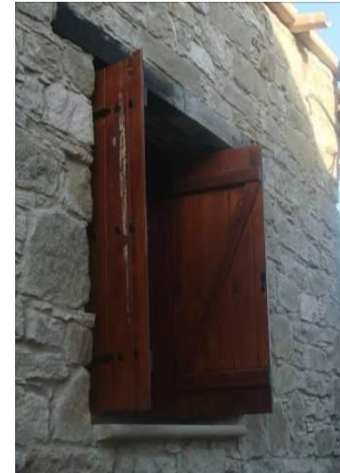
Λανθασμένη τοποθέτηση παραθύρου. Δημιουργεί σκοτία.
