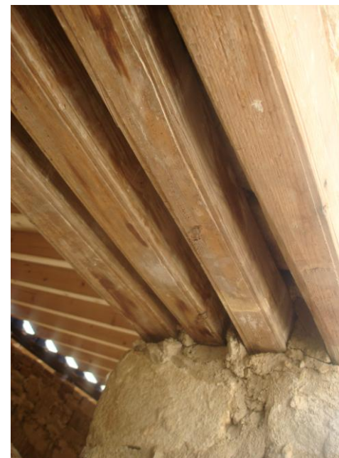
Αντικατάσταση ανωφλιού παραθύρας με νέα ξύλα
