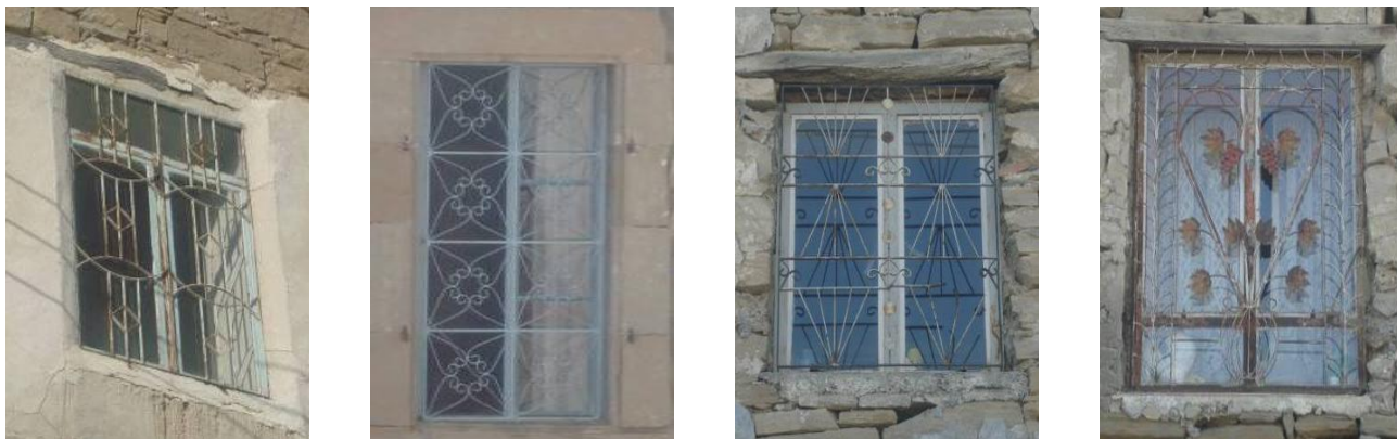
Μεταλλικές διακοσμητικές σιδεριές και παράθυρα σε αντικατάσταση του ξύλινου παραθύρου.
