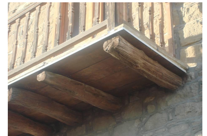
Αντηρίδες στο κάτω μέρος του εξώστη ενισχύουν τα βολιτζια.
