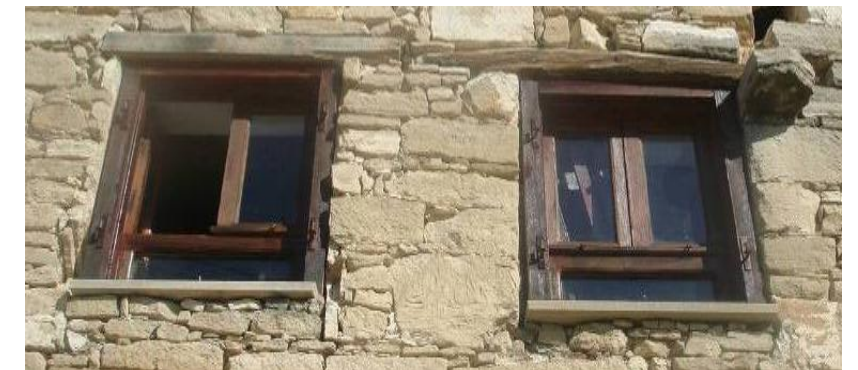
Λανθασμένος σχηματισμός στα παραθυρόφυλλα. Η υποδιαίρεση του σε τρία μέρη με τη δημιουργία φεγγίτη στο κάτω μέρος.
