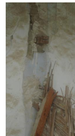
Λεπτομέρεια κατεστραμμένης τοιχοποιία. Σε αυτήν παρατηρούνται οι διάφορες στρώσεις υλικών που χρησιμοποιήθηκαν – καλάμια, ξύλα ασβεστοκονίαμα. Ξύλινα στοιχεία εγκάρσια στερεωμένα στην πέτρινη τοιχοποιία προεξέχουν. Σε αυτά στερεωνόταν (κάθετα) η μεσοτοιχία.
