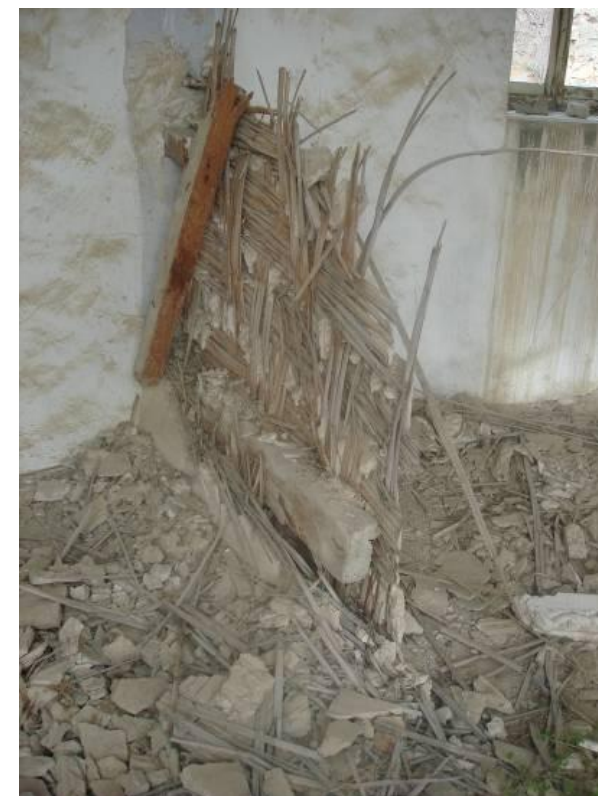
Λεπτομέρεια κατεστραμμένης τοιχοποιία. Σε αυτήν παρατηρούνται οι διάφορες στρώσεις υλικών που χρησιμοποιήθηκαν – καλάμια, ξύλα ασβεστοκονίαμα. Ξύλινα στοιχεία εγκάρσια στερεωμένα στην πέτρινη τοιχοποιία προεξέχουν. Σε αυτά στερεωνόταν (κάθετα) η μεσοτοιχία.
