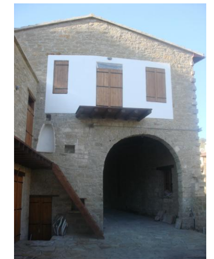
Το σκέπαστρο του εξώστη είναι αναπόσπαστο μέρος του και βρίσκεται σε πιο χαμηλό επίπεδο από τη στέγη.
