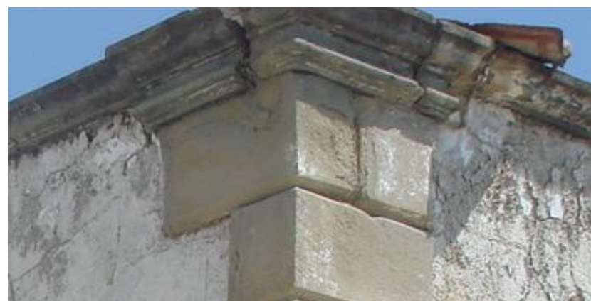
Λεπτομέρεια απόληξης στέγης και γωνιάς κτιρίου. Περιμετρικά της οροφής υπάρχει πελεκητή πέτρα
