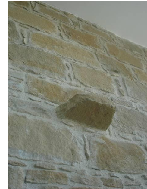
Η προεξοχή μιας πέτρας από την τοιχοποιία αποτελεί κάτι το φιαχτό. Η αρμολόγηση διαφέρει κατά πολύ από τον παραδοσιακό τρόπο δόμησης.
