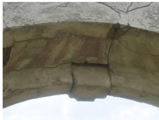
Λεπτομέρειες της θύρας εισόδου του σχολείου. Χαρακτηριστικό στοιχείο η πέτρα κλειδί η οποία εν μέρη αποκολλήθηκε από το τοξωτό υπέρθυρο. Στο πάνω μέρος της θύρας διακρίνονται υπό κλίση λαξευμένες πέτρες.
