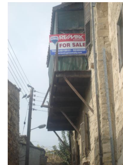
Αντηρίδες στο κάτω μέρος του εξώστη ενισχύουν τα βολιτζια.
