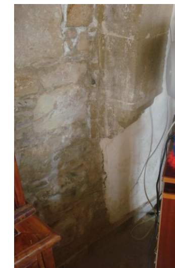
Κατάληξη καμάρας. Το τόξο φαίνεται να εφάπτεται της τοιχοποιίας
