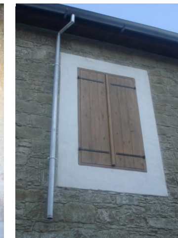
Προσθήκη υδρορροής. Αντικατάσταση παραθύρου και θύρας με νέα. Συντήρηση της πελεκητής πέτρας.
