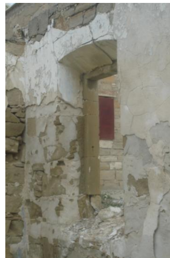
Εσωτερική όψη ανοίγματος. Η τοιχοποιία περιμετρικά από το παράθυρο κλίνει κωνικά.
