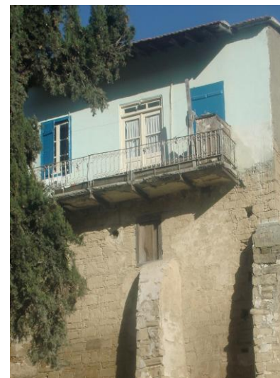
Εξώστη από μπετόν (μεταγενέστερη κατασκευή).
