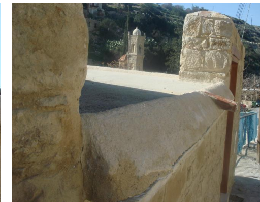
Δώμα και κρόδωμα (αλλοίωση κατά την αποκατάσταση).
