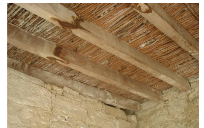
Λεπτομέρεια άνοψης στέγης. Εμφανές τα καλάμια και οι μορίνες. Από τις σχισμές των καλάμιών διακρίνεται
