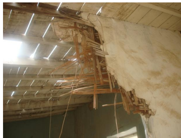
Λεπτομέρεια κατεστραμμένης τοιχοποιία. Σε αυτήν παρατηρούνται οι διάφορες στρώσεις υλικών που χρησιμοποιήθηκαν – καλάμια, ξύλα ασβεστοκονίαμα. Ξύλινα στοιχεία εγκάρσια στερεωμένα στην πέτρινη τοιχοποιία προεξέχουν. Σε αυτά στερεωνόταν (κάθετα) η μεσοτοιχία.
