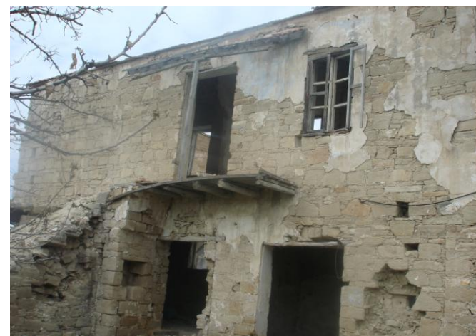
Εξώστη από μπετόν (μεταγενέστερη κατασκευή).
