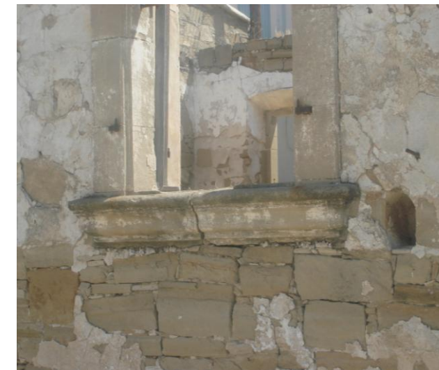
Εξωτερική όψη ανοίγματος. Περιμετρικά από το παράθυρο η πελεκητή πέτρα.
