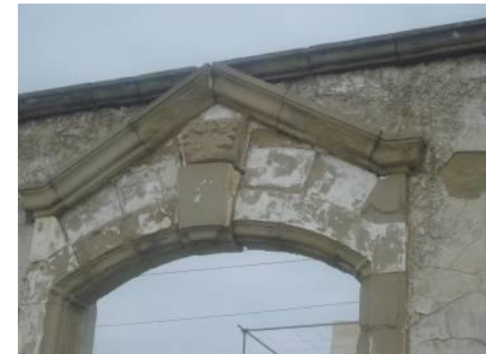
Λεπτομέρειες της θύρας εισόδου του σχολείου. Χαρακτηριστικό στοιχείο η πέτρα κλειδί η οποία εν μέρη αποκολλήθηκε από το τοξωτό υπέρθυρο. Στο πάνω μέρος της θύρας διακρίνονται υπό κλίση λαξευμένες πέτρες.
