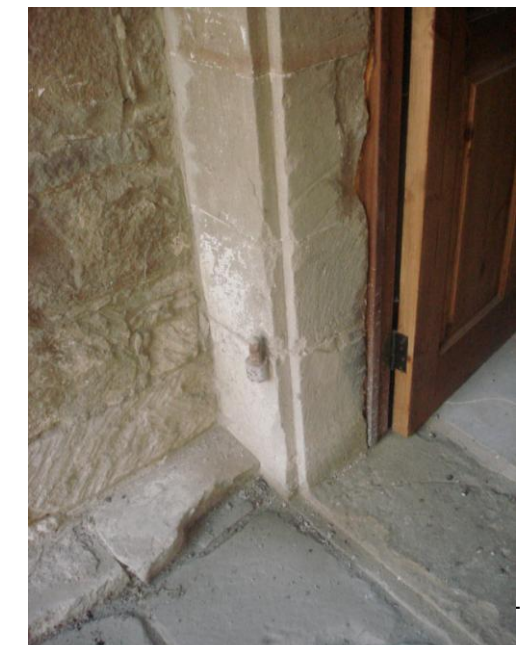
Οι μεντεσές στη τοιχοποιία υποδηλώνει ότι υπήρχε πόρτα στο σημείο αυτό
