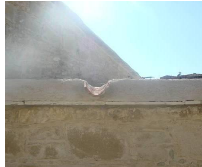
Λεπτομέρεια κροδάματος κατοικίας με χολέρα από κεραμίδι για το νερό της βροχής.
