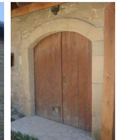
Προσθήκη υδρορροής. Αντικατάσταση παραθύρου και θύρας με νέα. Συντήρηση της πελεκητής πέτρας.
