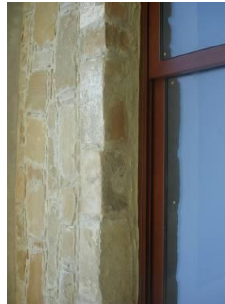
Πόρτες και παράθυρα από αλουμίνιο σε απόχρωση ξύλου.
