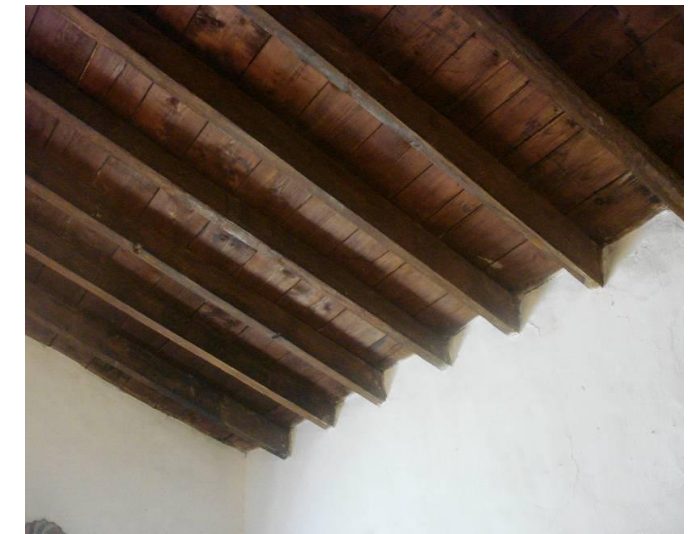
Λεπτομέρεια άνοψης στέγης με σανίδια (σανίδωμα). Οι μορίνες φαίνονται να εισχωρούν ερμητικά στην τοιχοποιία.
